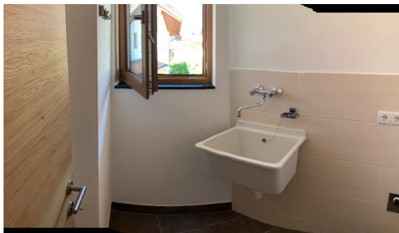
Wirtschaftsraum für Waschmaschine, Trockner etc. mit Fenster nach West
