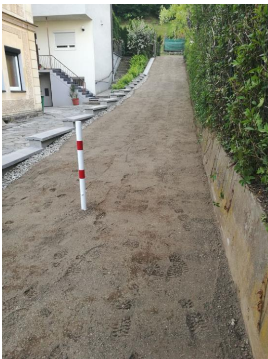
neu befestigter Stichweg mit Mauer
