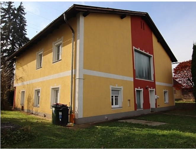
290m 2 Mehrfamilienhaus in Grafenstein - St. Peter
