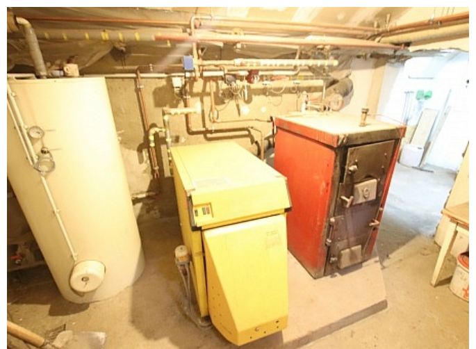
290m 2 Mehrfamilienhaus in Grafenstein - St. Peter
