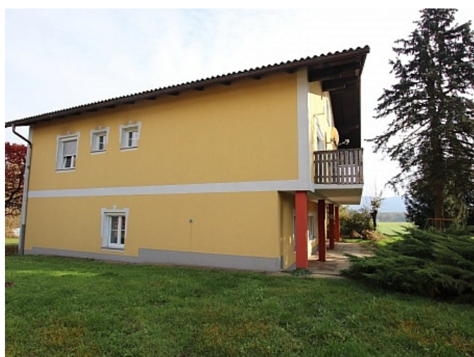
290m 2 Mehrfamilienhaus in Grafenstein - St. Peter
